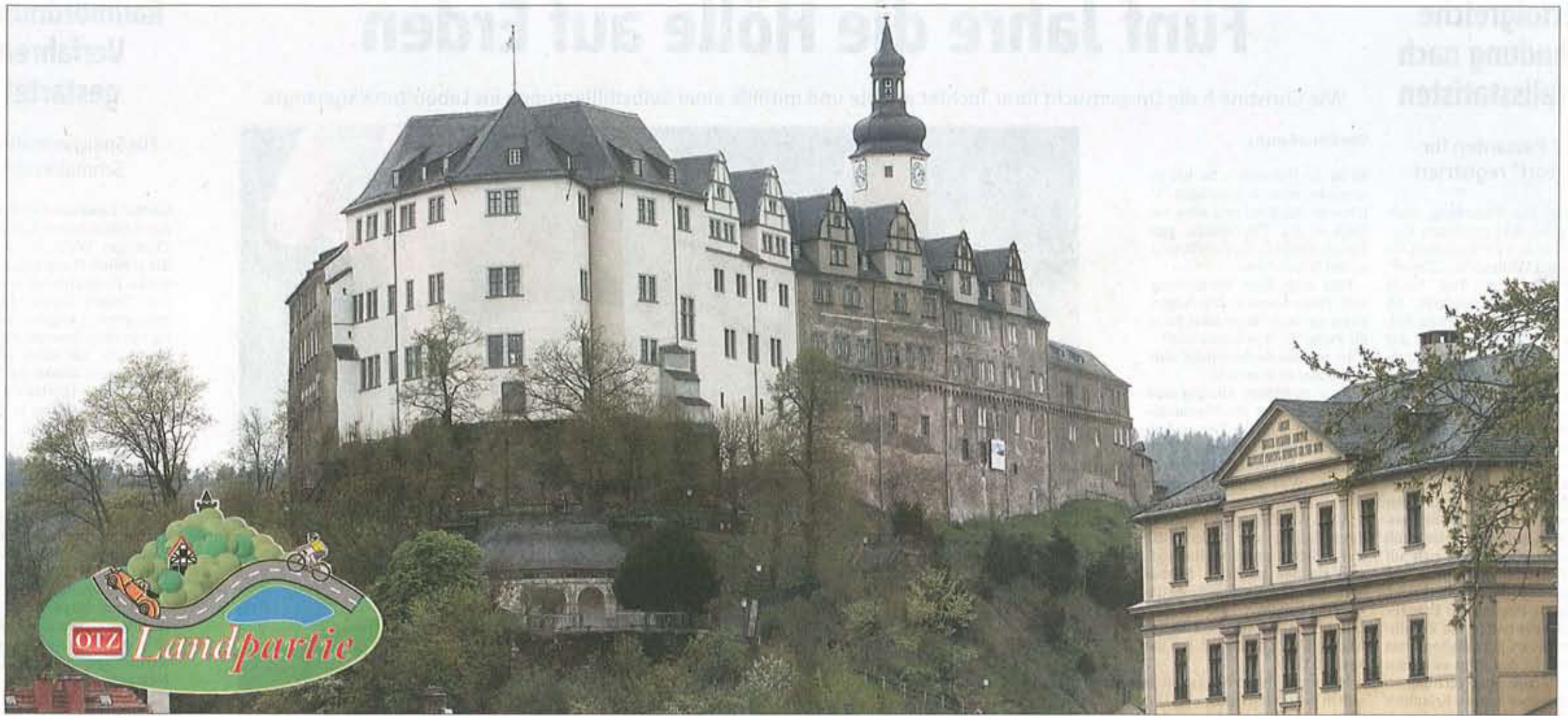
Das Obere Schloss in Greiz thront quasi auf einem 50 Meter hohen Berg inmitten der Stadt. Das Museum mit der reußengeschichtlichen Dauerausstellung ist im sanierten Südflügel zu finden.
