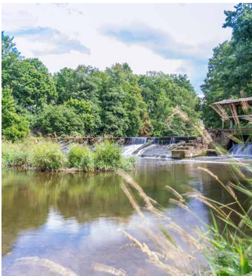
Elsterwehr in Neumühle
