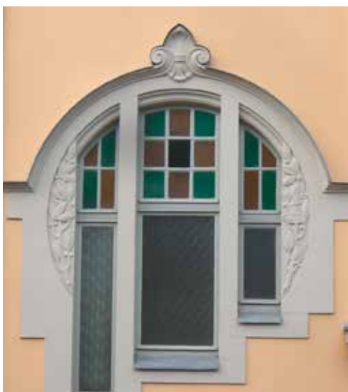
Bild 3: Treppenhausfenster in der Leonhardtstraße 21
