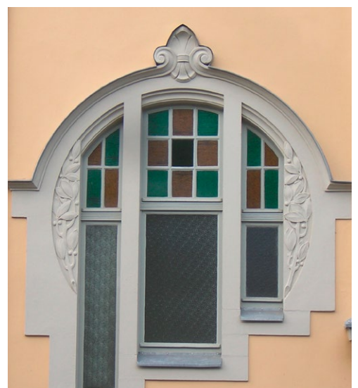
Bild 3: Treppenhausfenster in der Leonhardtstraße 21
