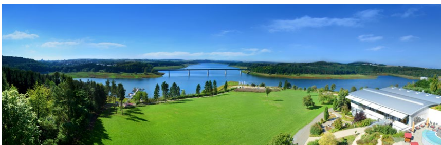
Blick auf die Talsperre Zeulenroda
