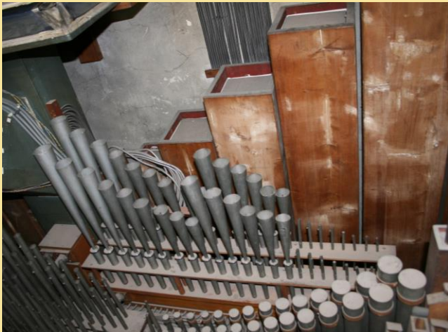
Stark verschmutztes Pfeifenwerk vor der Restaurierung
