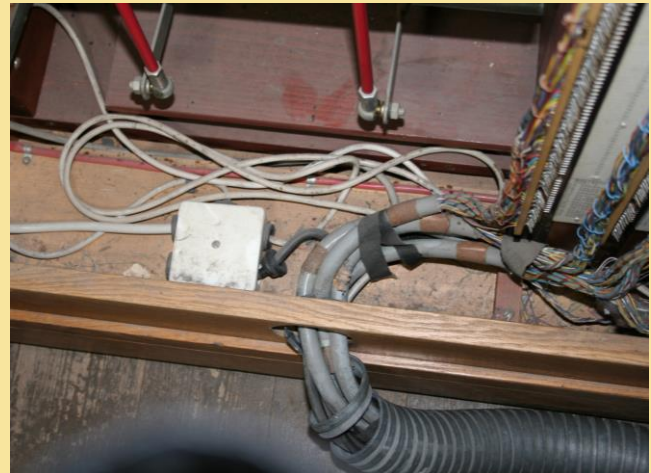
Kreativ verlegte elektrische Leitungen an den Grenzen der Betriebssicherheit
