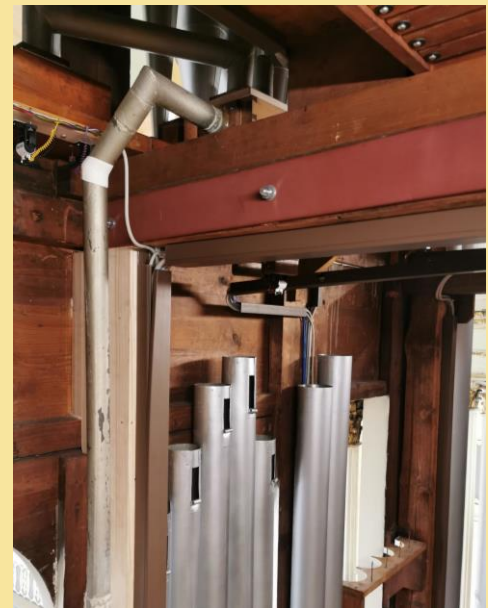
Kondukte (linkes Rohr) und neu verlegte Kabel hinter dem Prospekt
