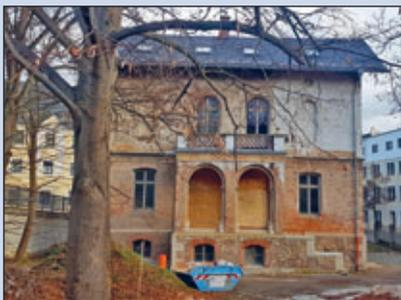
Bild 3: Unter Einsatz von Städtebaufördermitteln wurden bereits durch den Vorbesitzer die Dächer, einschließlich Dachentwässerung und der Balkon über der baufälligen Vorhalle gesichert. Ansicht von 2021.
