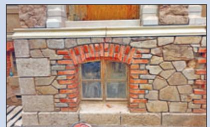
Bild 6: Als besonders aufwendig stellt sich die Sanierung des hohen Bruchsteinsockels und aller anderen Natursteinelemente dar.
